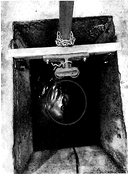
損壞污水泵房氣泵
