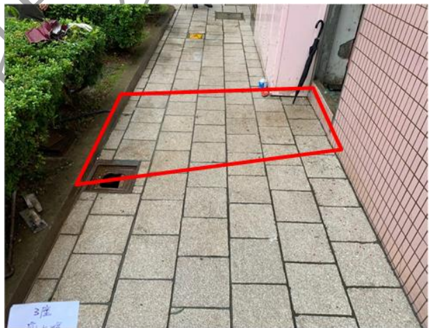
挖掘泵房對出地面位置，維修地底沖廁喉
