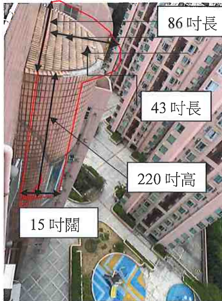
位置(1)修葺瓦片面積約(43+22)平方呎= 65 平方呎
