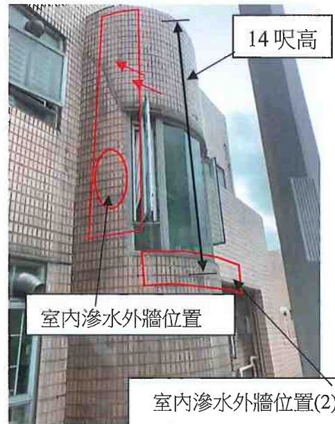
位置(2)修葺外牆瓦片面積約約 10 平方 呎
