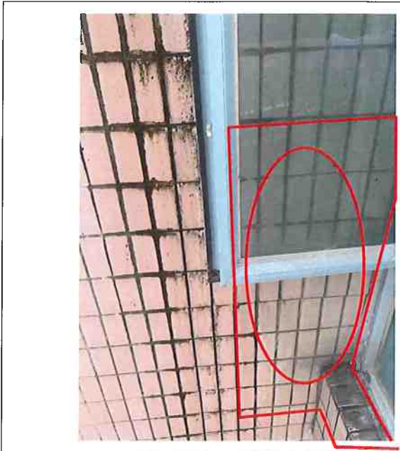
外牆瓦片有空泡情況(紅圈)
