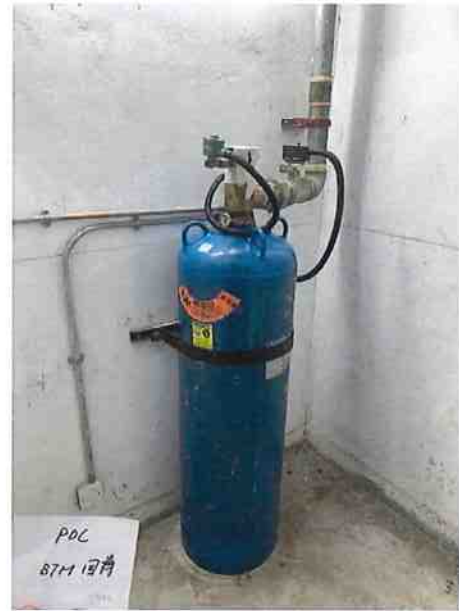
測試完成運回安裝
