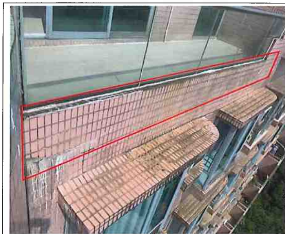
維修外牆瓦片位置(紅線範圍)約高 26 吋 x 長 19 呎(41 平方呎)
