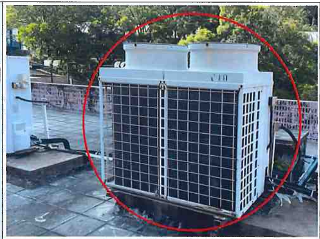
更換前(室外機)
