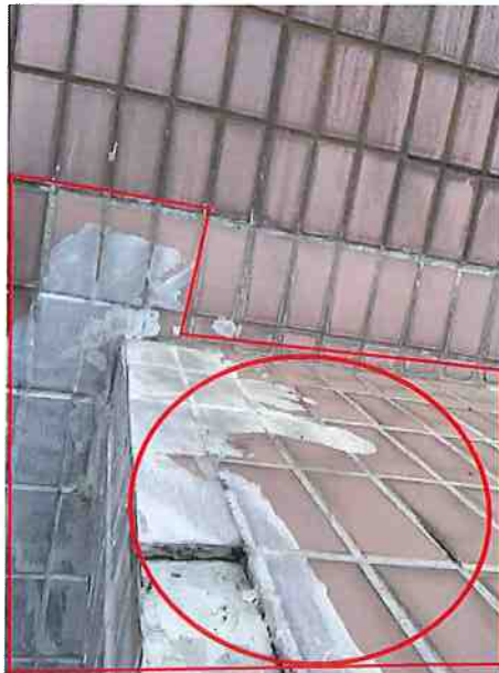
外牆瓦片鬆脫及有空泡情況(紅圈)
