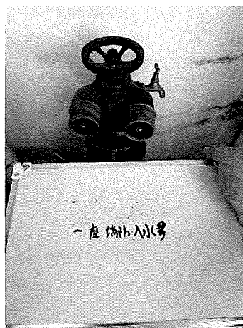
拆除 1-7 座消防入水掣檢查(前)
