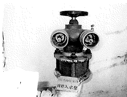
項目 1.2 - 拆除第 1 至 7 座消防入水掣及止回閥檢查
