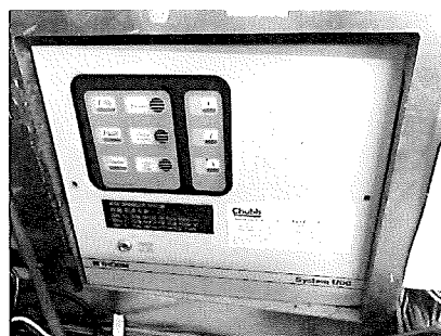
項目 3.1 - 更換消防花灑系統控制掣箱
