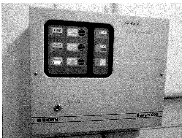
更換 BTM 自動滅火系統控制箱(前)
