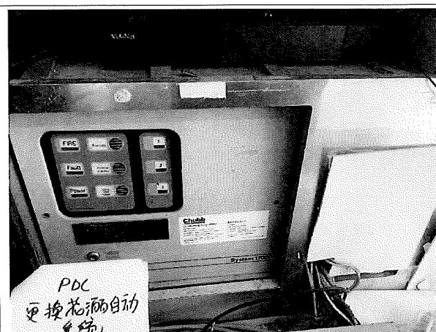
更換自動花灑系統控制箱(前)
