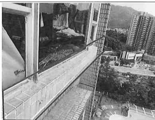
維修室外位置
