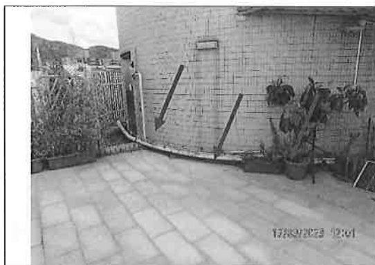
1-15 樓 單位廁水供水喉(紅箭咀)
