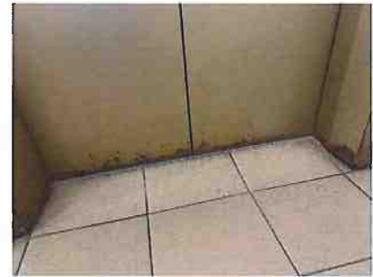
第 8 座 1 及 2 號金屬門表面銹蝕及磨損
