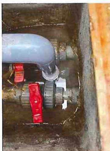
於池邊回水位置唧膠封罅隙(紅線)，暫時未有發現滲水
