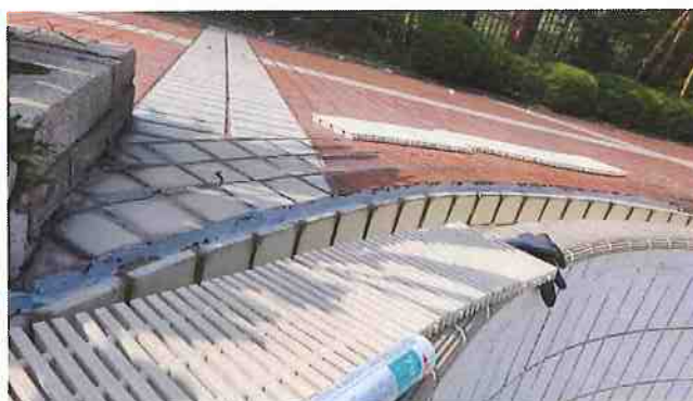
於池邊回水位置唧膠封罅隙(紅線)，暫時未有發現滲水
