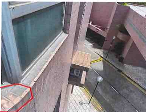
更換外牆瓦片位置(紅線)
