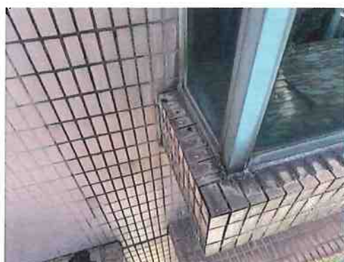
更換外牆瓦片位置(紅線) 有空鼓(紅箭) 維修面積約 10 平方尺(14 尺 x 8 吋)
