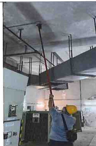
進行中(測試火牛房煙霧感應器)
