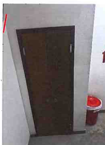
4. 安裝燈喉至 1 樓磁力鎖供電房
