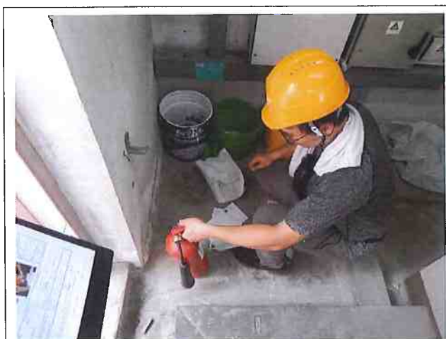
進行中(檢查各滅火筒)
