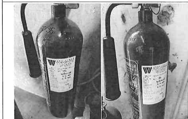
更換 2 支 3KG 漏氣滅火筒完成
