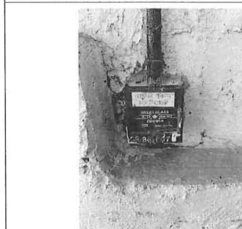
更換損壞消防襟手掣(更換前)
