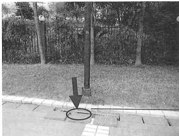
近 J5 泳池燈柱側，暗渠內發現裂縫有水滲出。
