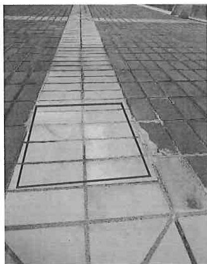
工程部挖掘相片上紅方格位置檢查水源
