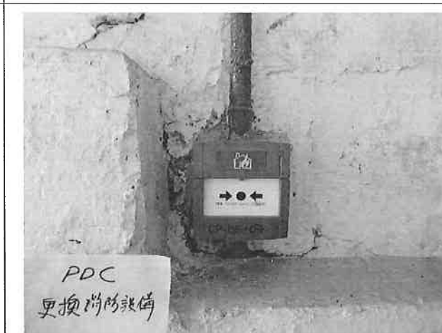
更換損壞消防襟手掣(更換後)
