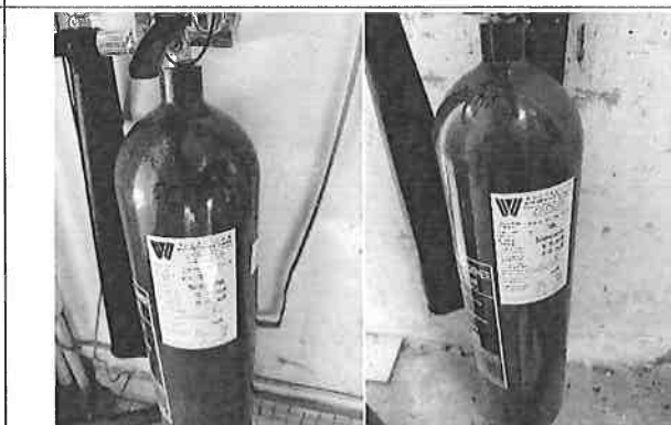
更換 2 支 5KG 漏氣滅火筒完成
