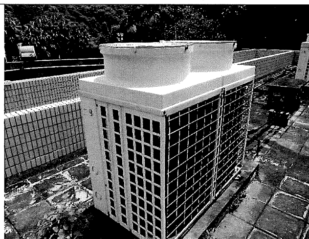
更換前(室外機)
