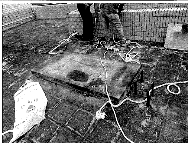
更換中(室外機)
