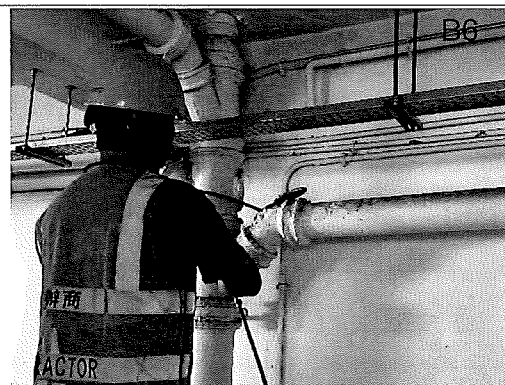
進行高壓通渠
