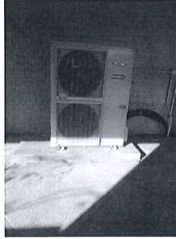
更換後(室外機)
