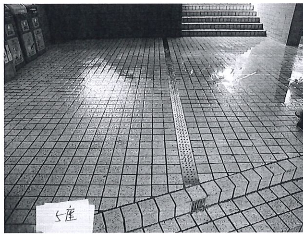
第 5 座完成後試水
