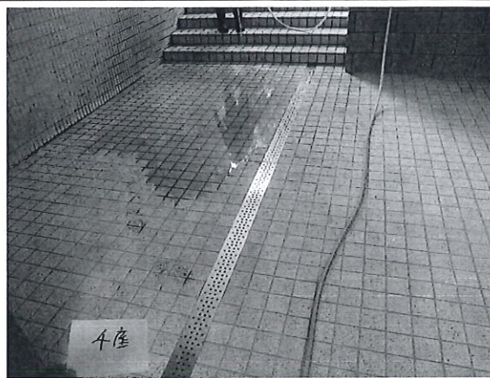
第 4 座完成後試水
