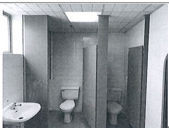
上層女廁更換前
